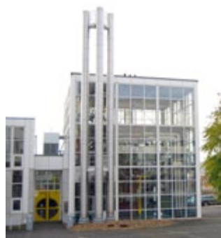
Auch die Energiezentrale der FH dient Forschungszwecken
