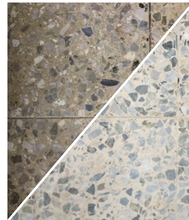
Der Vorher-/Nachhervergleich auf dem bearbeitetem Steinboden in der Schule zeigt ohne viel Chemieeinsatz ein beeindruckendes Ergebnis.
