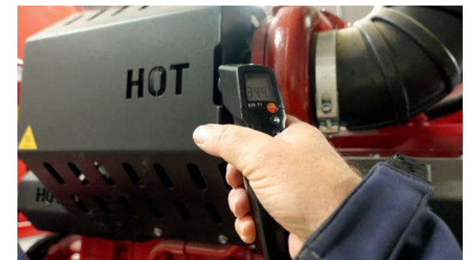
Bei der Prüfung der Sprinkleranlage wird es laut und heiß für die Kollegen – Gehörschutz und Temperaturmessung sind Pflicht
